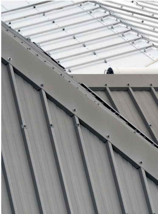
用於金屬板材的卷鋼塗料在建築方面的應用
